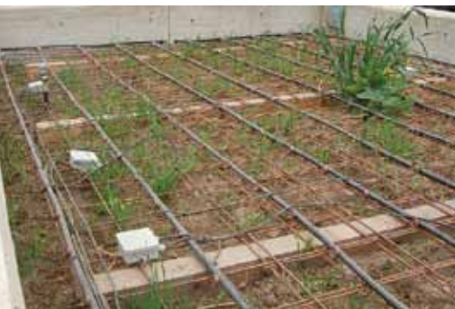
Phytobac-Projekt: Das Spritzenreinigungswasser, auch von der Außenreinigung mit dem Hochdruckreiniger, enthält Restmengen von Pflanzenschutzmitteln. Es wird durch eine Waschplatte aufgefangen und in einem Tank gesammelt. Von dort aus wird das Wasser periodisch in einem überdachten Phytobac-Behälter, gefüllt.
